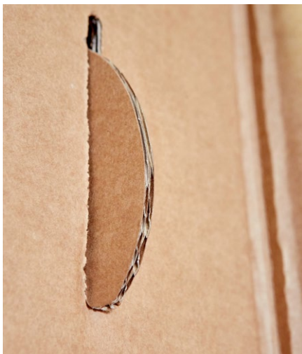
„Bohne“ – Steckverbindung zwischen zwei Wänden
